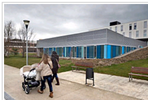
Exterior del Centro de Atención Temprana de Sarriguren.
