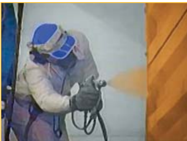
fig.3 Proyección con equipo de Airless
