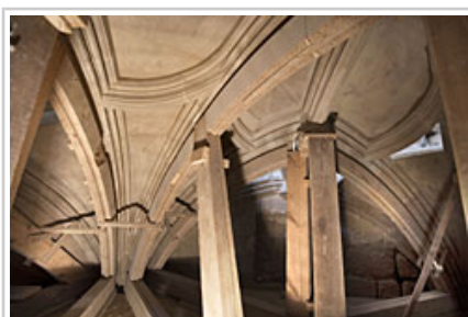
Detalle de las bóvedas que se están reconstruyendo.
