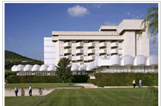
Vista del Hospital D (Clínica Ubarmin)
