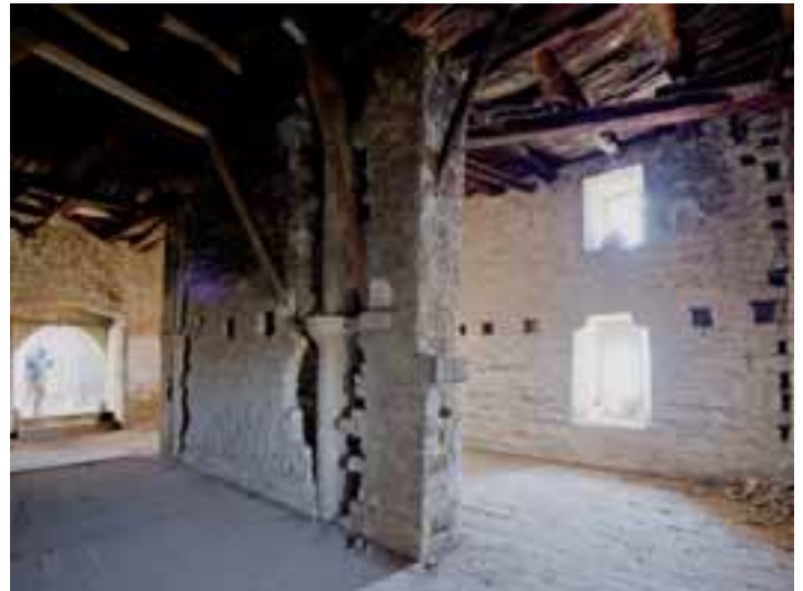
Planta primera de la casa parroquial antes de la restauración
