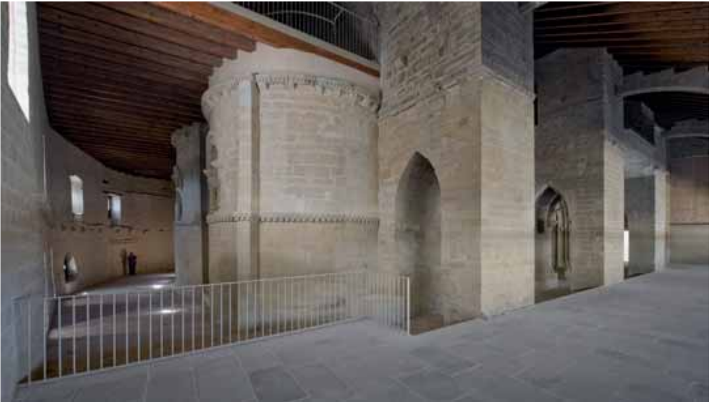
Pórtico norte y la ronda de los ábsides, ambos restaurados
