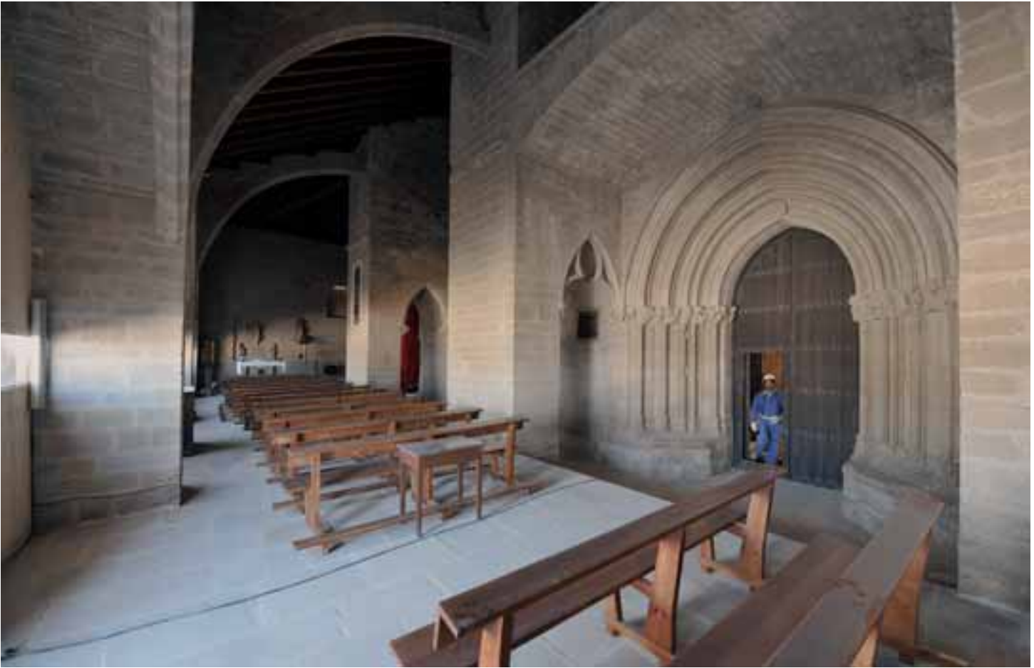
El pórtico habilitado como capilla durante las obras de la iglesia
