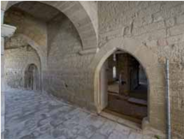
Acceso a la planta primera de la casa parroquial, antes de la restauración
