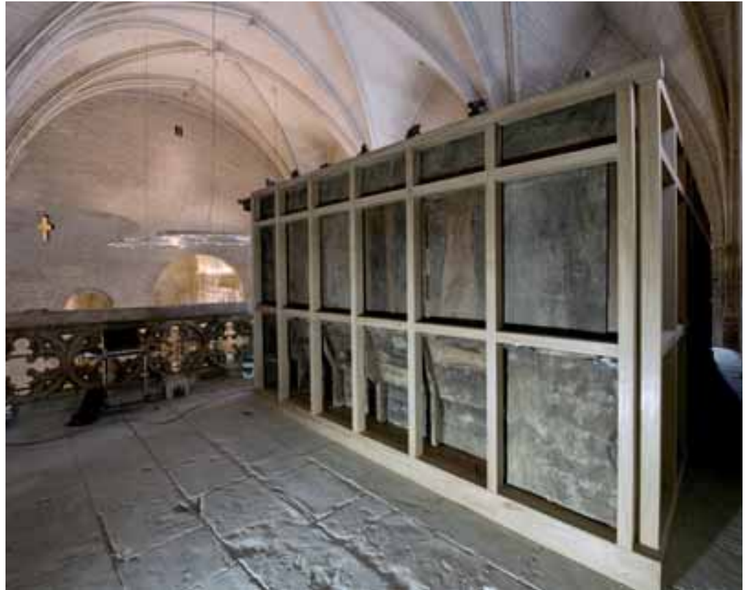
El coro después de la restauración. Trasdós de la sillería
