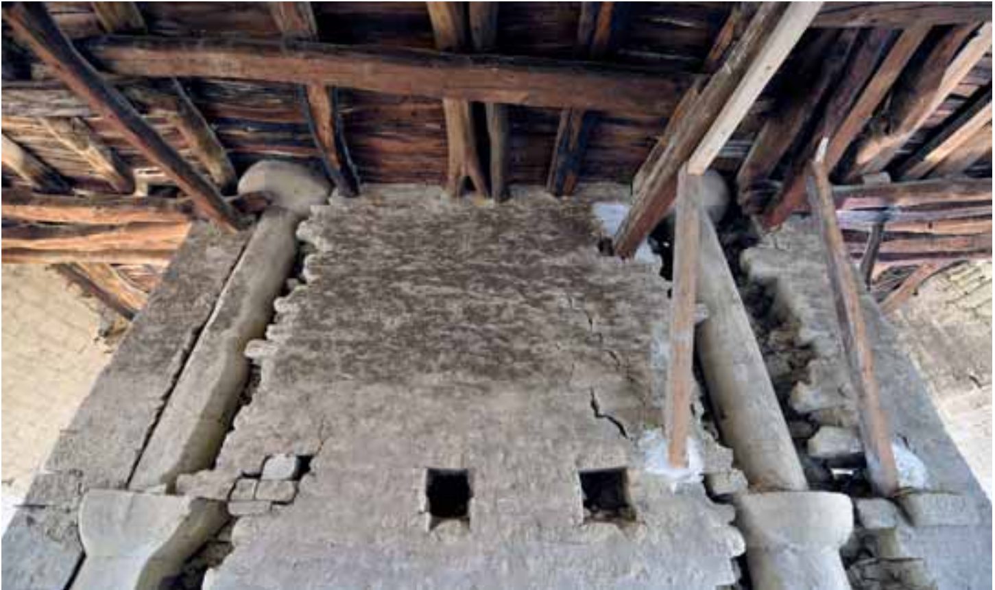
Estructura de la primera planta de la casa parroquial, antes de la restauración
