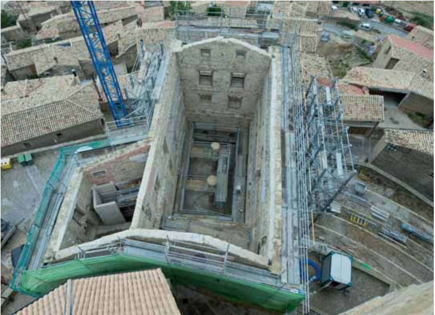
La casa parroquial y el edificio anejo donde se puede ver la caja del ascensor en construcción
