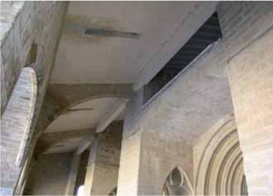
El pórtico norte antes de la restauración
