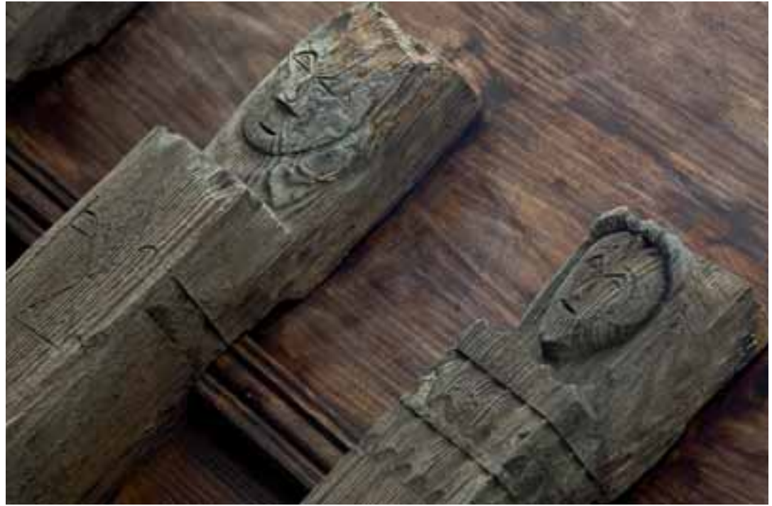
Detalle de las testas de los cabios del mirador de poniente
