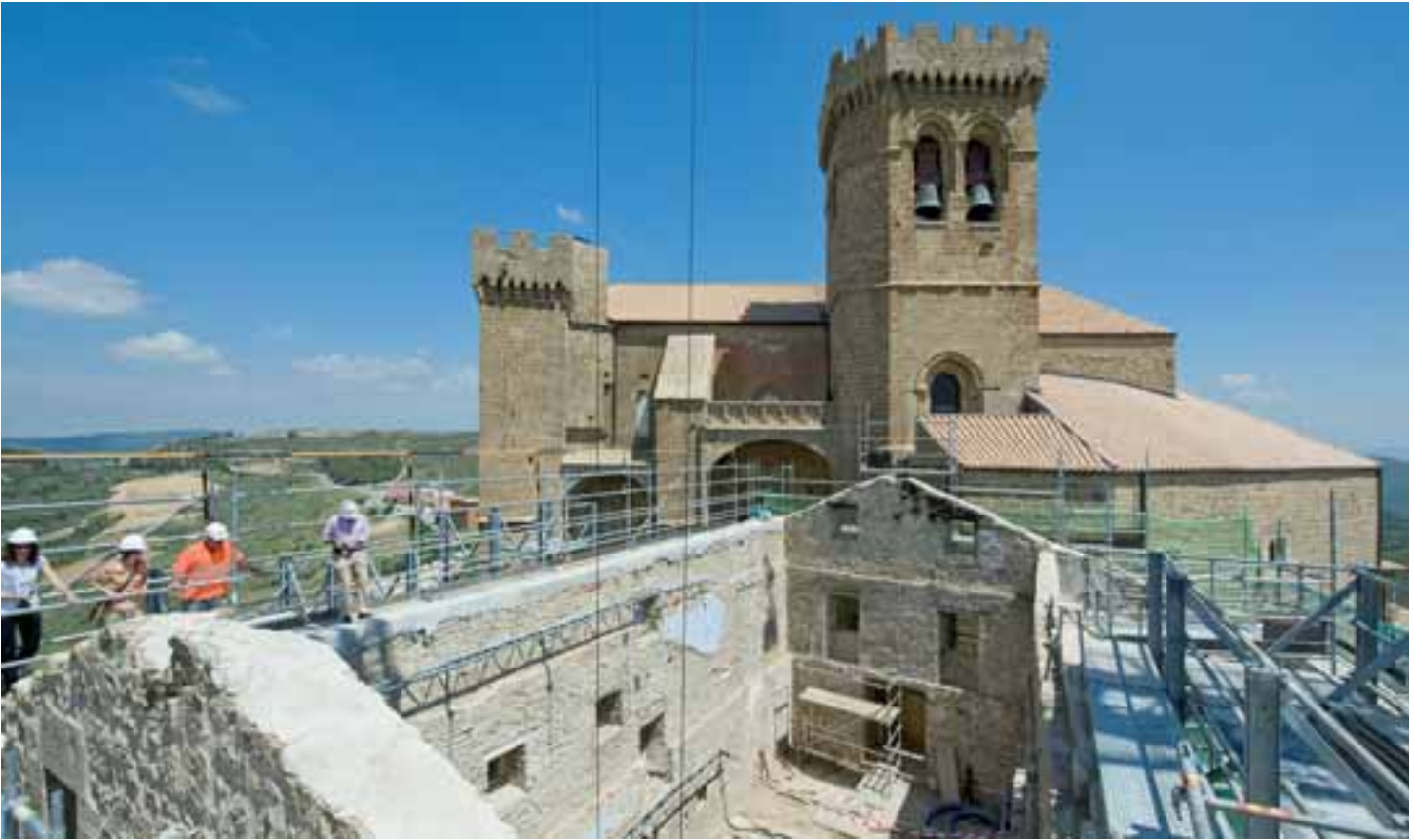
Vaciado de la casa parroquial
