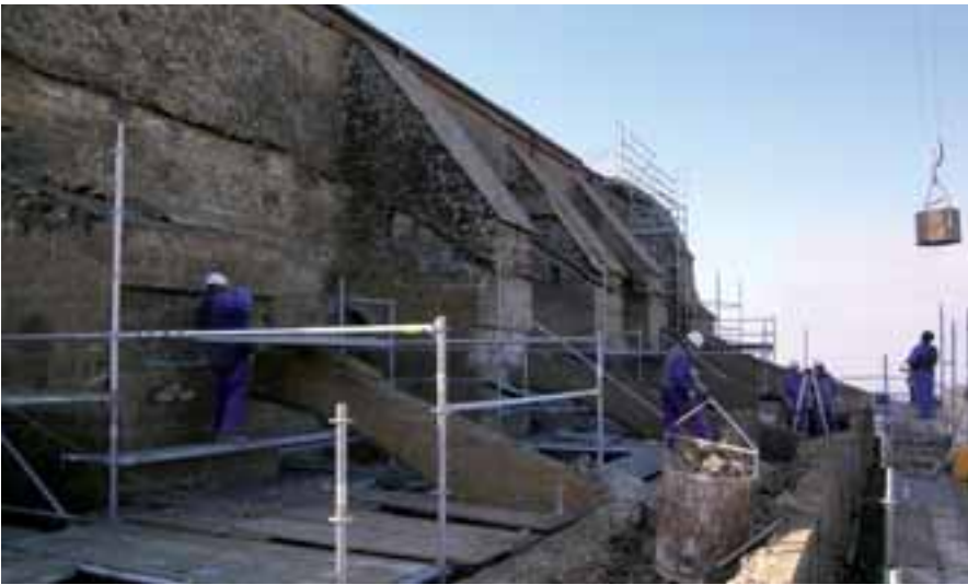
Demolición de la estructura de hormigón del "claustro" o pórtico norte
