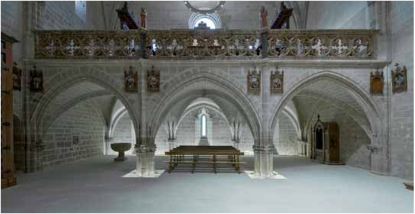
Antepecho del coro y sotacoro restaurados
