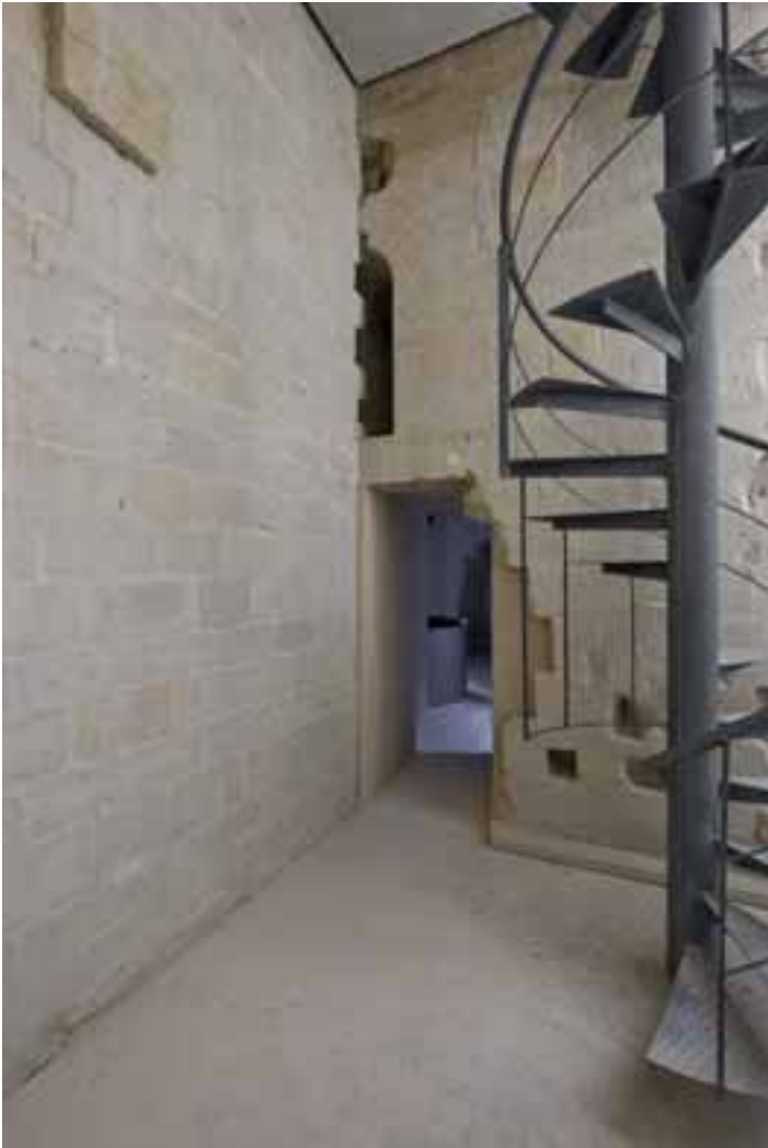
Arranque de la escalera de la torre de los Picos. Al fondo, la "casa del sacristán"
