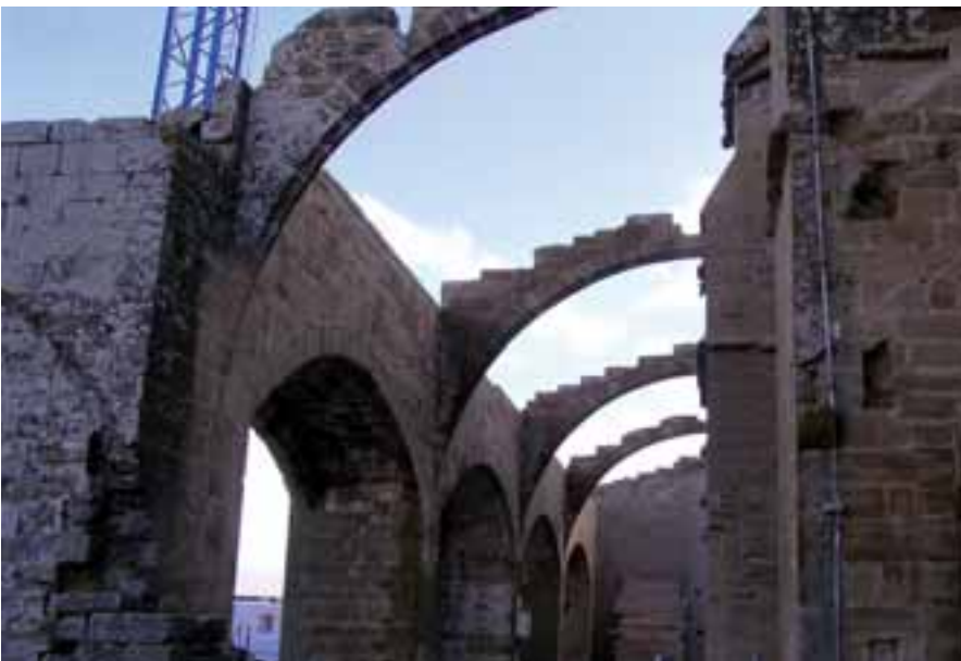
El pórtico antes de colocar la nueva estructura de madera
