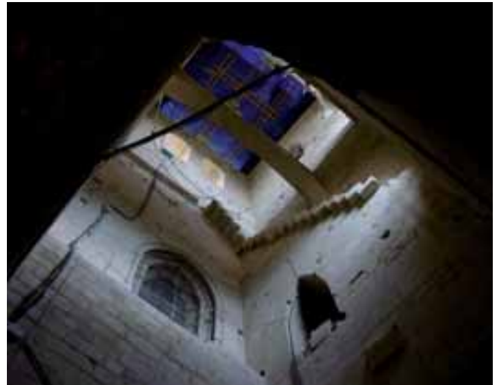
Interior de la torre de los Picos durante las obras. Vaciado de la torre
