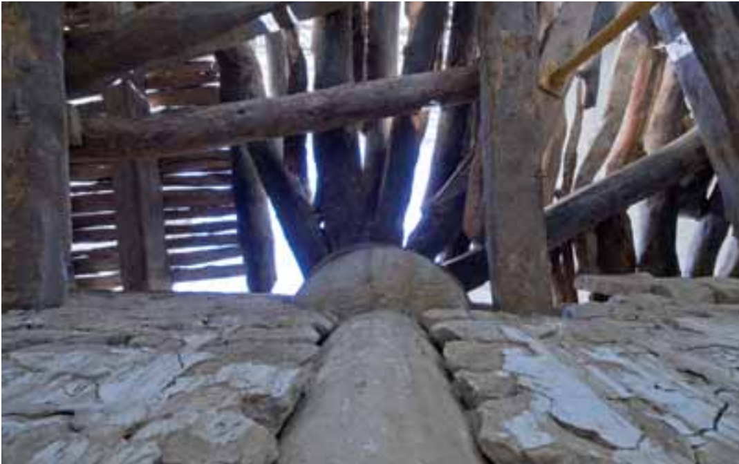
Detalle de la estructura radial de la planta baja durante las obras
