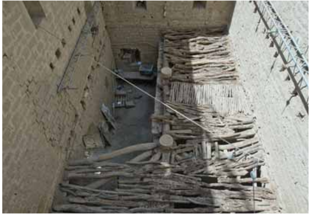
Desmontado de la estructura de techo de planta baja
