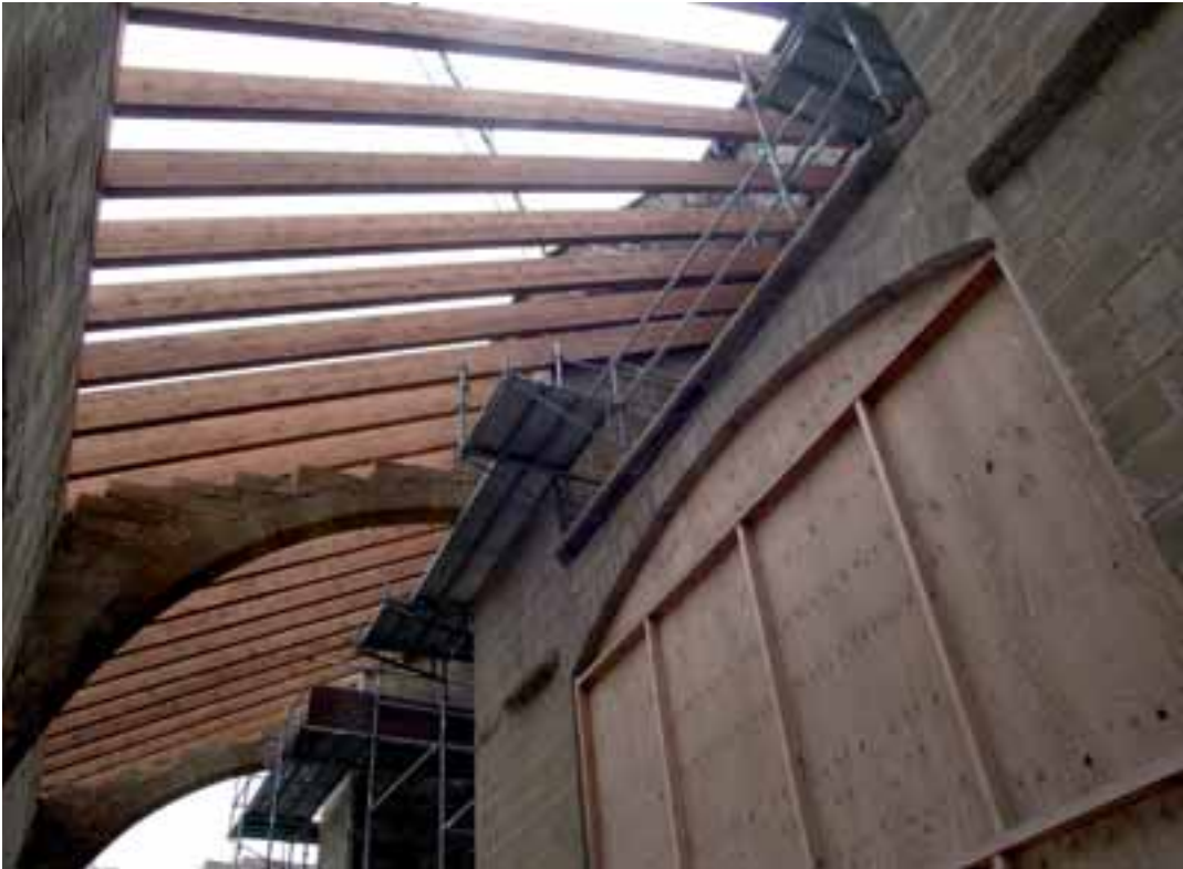
Montaje de la nueva estructura de madera del pórtico
