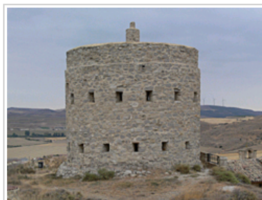
Torreón de fusileros de Miranda de Arga.
