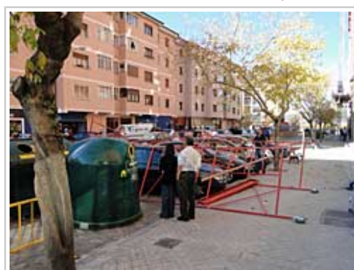
Imagen del andamio caído.
