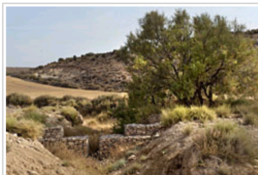
Uno de los diques realizados.
