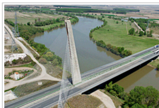
Puente sobre el río Ebro en la Autopista de Navarra (AP-15).
