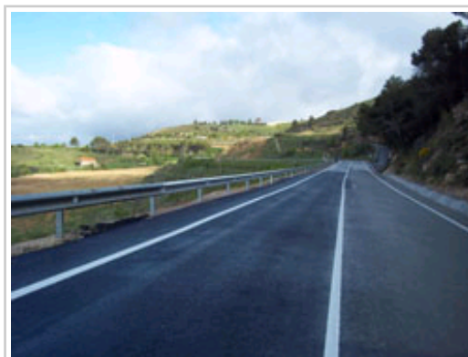
Imagen de la carretera NA-5310 próxima a Ujué, tras su reparación.
