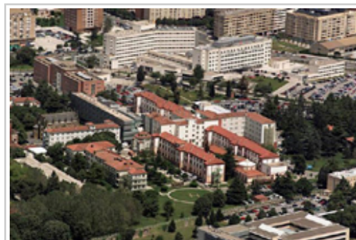
Vista aérea del Complejo Hospitalario de Navarra.
