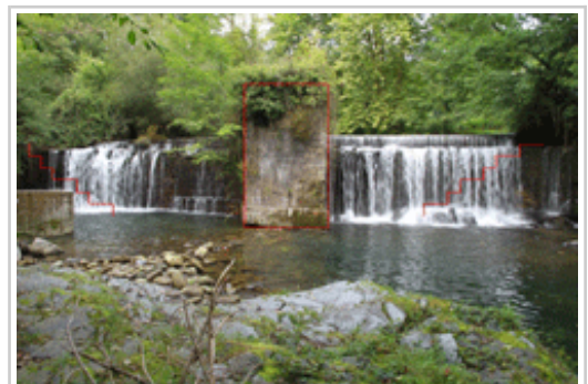
Presa Igerizarreta de Ituren. En rojo, los elementos singulares que se van a conservar.
