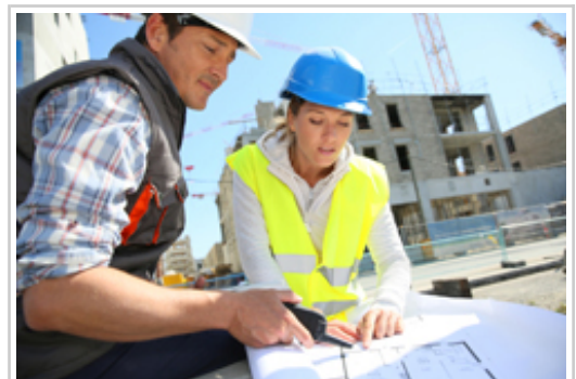
Los profesionales en un edificio en construcción.
