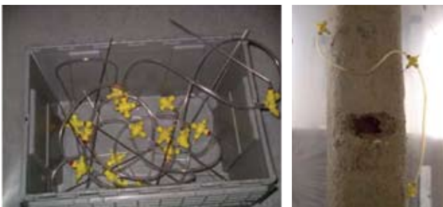
Figura A3.16 a y b Sistema de humectación por inyección, diseñado para humectar materiales friables en profundidad y detalle de aplicación
