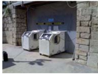
Figura A3.8 Extractores de aire para generar presión negativa en el interior de una burbuja
