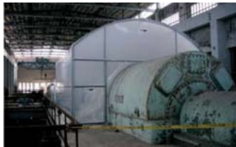
Figura A3.7a Burbuja para la retirada de los calorifugados de una turbina en una instalación industrial
