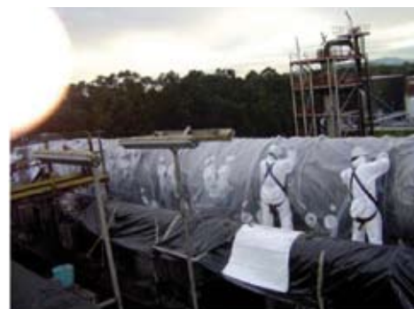
Figura A3.14 Colocación de los sacos de guantes para trabajar en una tubería
