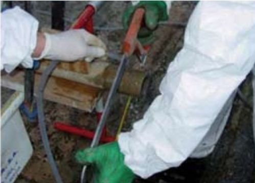
Figura A3.20 Corte de tubería con sierra manual y aporte de agua
