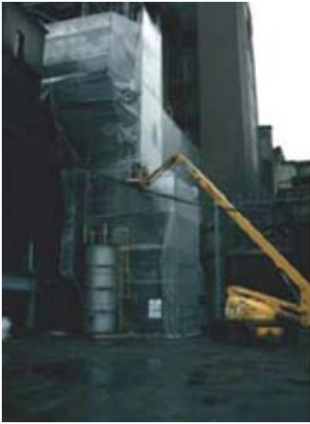
Figura A3.7b Burbuja para la retirada de calorifugados y otros MCA de una caldera en una central térmica
