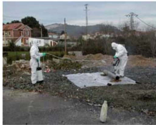
Figura A3.3 Ensayo de distintas herramientas de trabajo para corte de tubería. La colocación de una lámina de plástico en el suelo evita la diseminación de los residuos y facilita su recogida y limpieza de la zona
