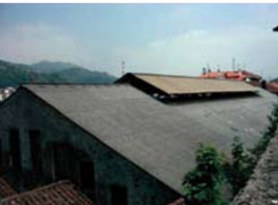
Figura A1.18 Placas onduladas y planas (cubiertas)
