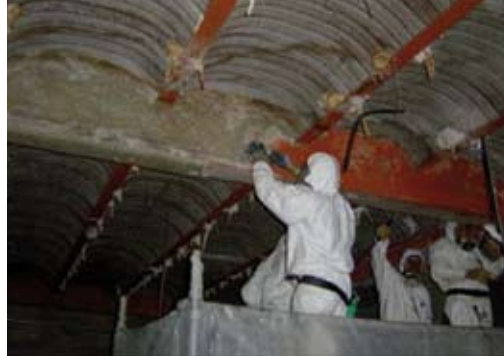
Figura A3.17 Retirada con herramienta manual (rasqueta) del recubrimiento ignífugo a base de mortero de amianto (MCA friable) en un edificio
