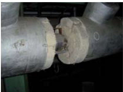
Figura A1.30 Detalle de calorifugado (coquilla)
