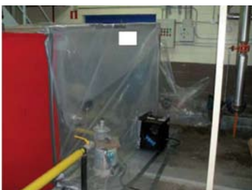
Figura A3.12 Minicubierta para un trabajo de mantenimiento
