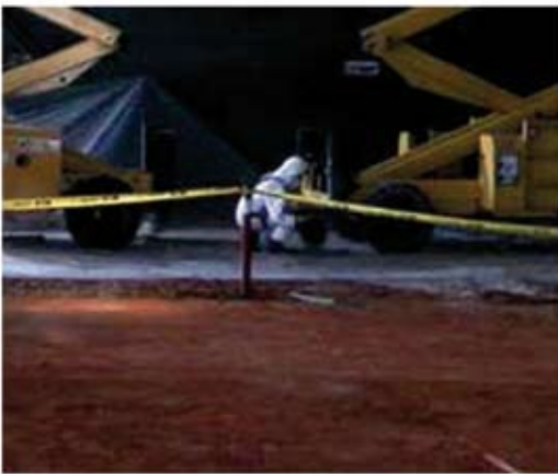
Figura A3.1 Limitación de la zona de trabajo para la retirada de una cubierta de fibrocemento
