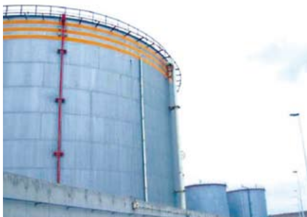
Figura 2. Muchos hidrocarburos se almacenan a temperatura y presión atmosféricas. Por tanto, si la sustancia emite vapores y en el interior hay aire, hay que aplicar el RD 681/2003.
