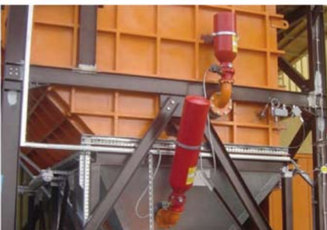
Figura 34. Sistema de supresión de explosiones: un detector dinámico detecta la explosión (presión), da señal al panel de control y activa los supresores.
