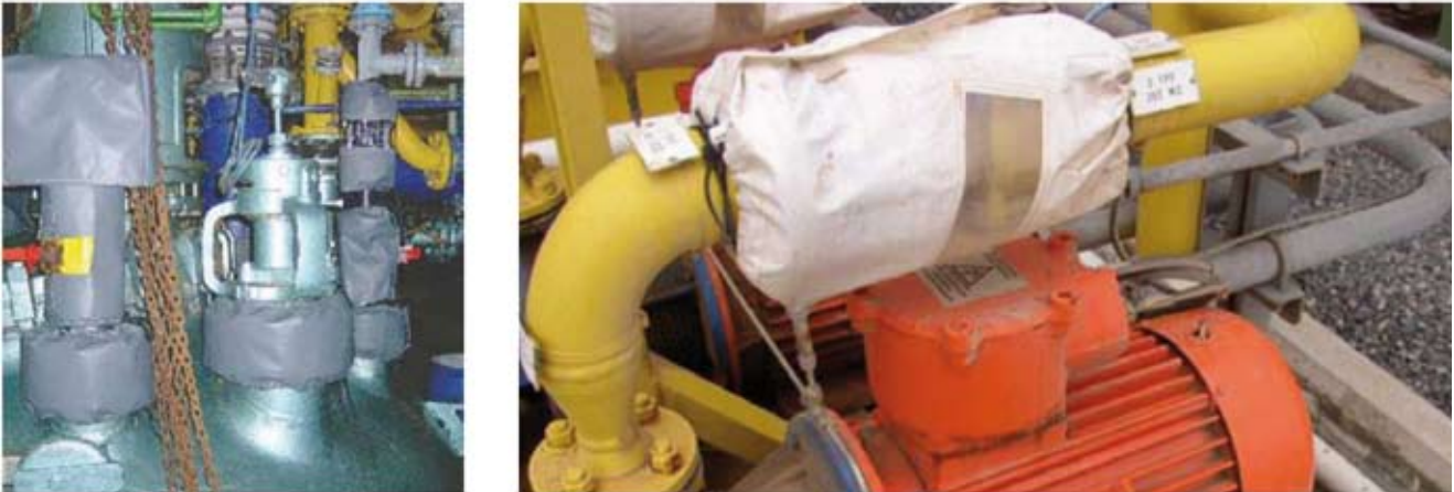
Figura 30. Sistema de control de escapes.
