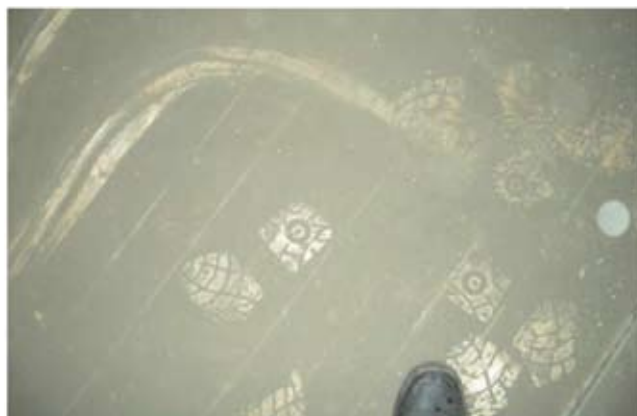
Figura 12. La existencia de capas finas de polvo depositado puede ser suficiente para formar una atmósfera explosiva peligrosa. Cuanto más fino y seco sea el polvo inflamable, mayor peligrosidad. El polvo depositado debe ser eliminado.
