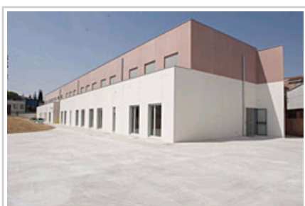
Vista exterior del nuevo edificio.
