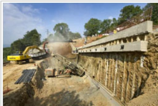
Imagen de la pantalla de micropilotes construida para estabilizar la ladera sur del túnel.
