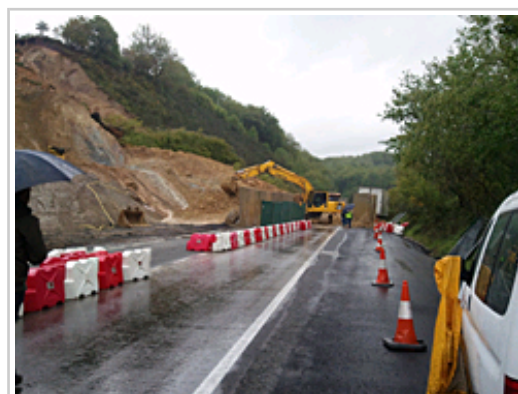
Imagen de los trabajos realizados a la altura del desprendimiento.
