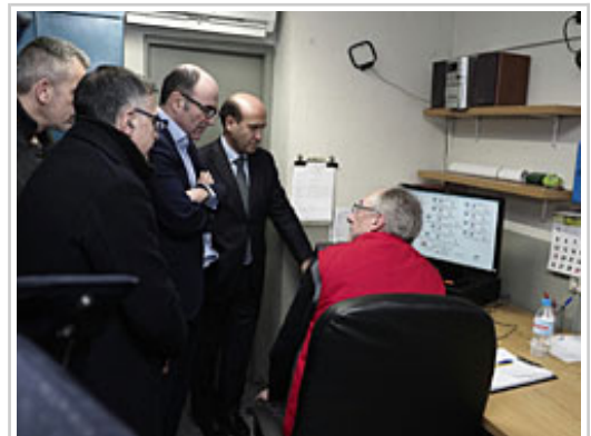
Ayerdi en la sala de control del sistema de calefacción.
