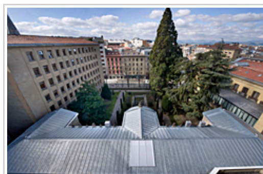
Vista general de la nueva cubierta del antiguo Archivo.
