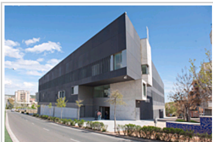
Imagen exterior del nuevo edificio que acogerá a los juzgados de Tudela
