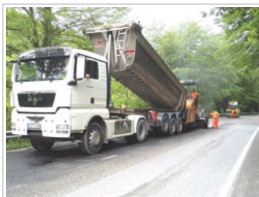
Trabajos de parcheo en la carretera de Belate.
