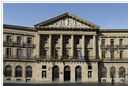
Fachada del Palacio de Navarra.
