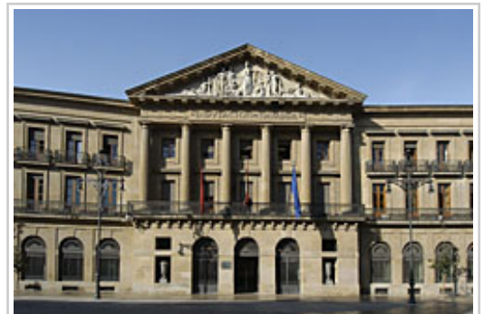
Fachada del Palacio de Navarra.
