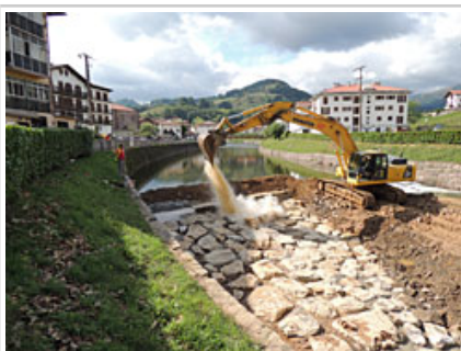
Ensayo de funcionamiento.
