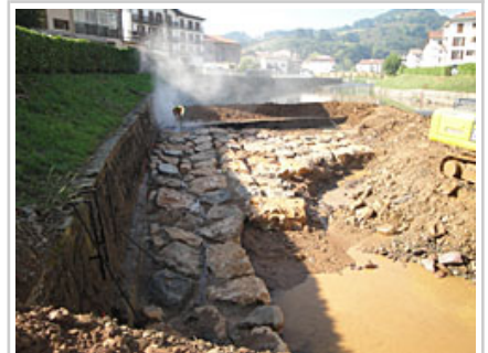
Ejecución de los trabajos.
