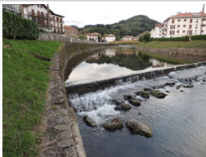
Presa de 1,5 m. de desnivel antes de la construcción de la rampa.
