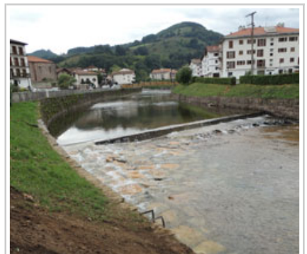
Rampa en funcionamiento. Obstáculo permeabilizado.
