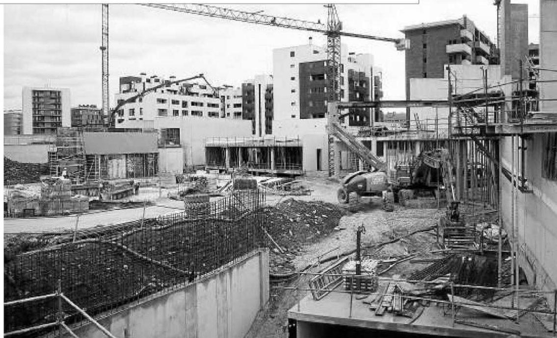
Una zona en construcción. Foto: D.N.
