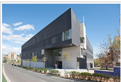
Imagen exterior de la nueva sede de los juzgados de Tudela.
