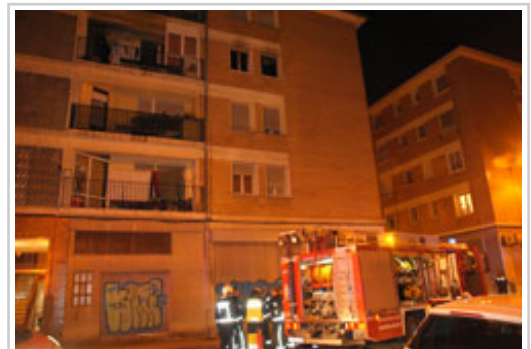
Los bomberos ante la casa en cuyo tercer piso se ha producido el incendio.
