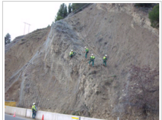
Imagen de los trabajos de colocación de malla para estabilizar taludes en el área de Sangüesa, para evitar desprendimientos sobre la calzada.
