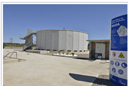
Vista general de la depuradora de Rada.
