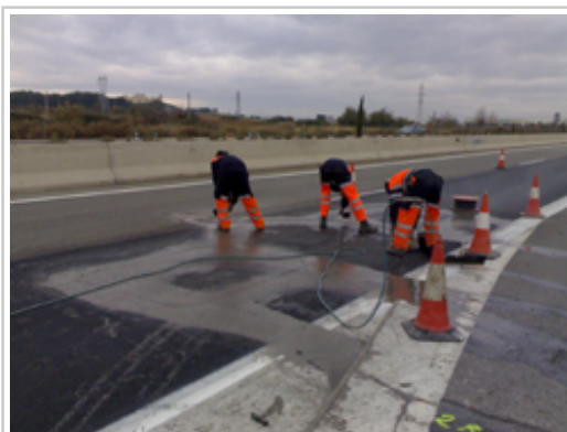
Operarios instalan el cableado del lazo magnético en las carreteras.
