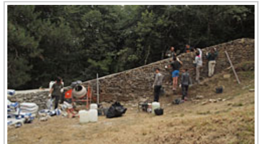
Jóvenes y monitores trabajan en el afianzamiento de un muro.
