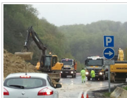
Trabajos sobre la N-121-A.
