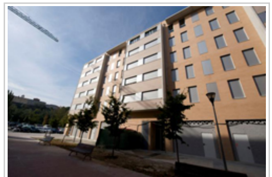
Vivienda protegida en Rochapea.
