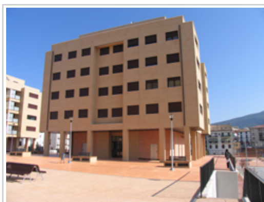
Viviendas de Protección Oficial en Aoziz.
