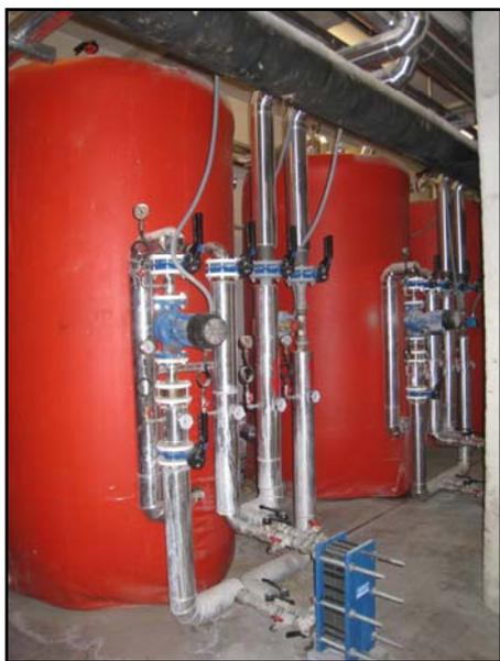
Para la producción del ACS se realiza un precalentamiento a 45°C del agua mediante la instalación de geotermia. Posteriormente el agua se calienta a través de unos intercambiadores de placas y es almacenada en 3 depósitos de 4.000l a una temperatura de 60-65°C.
