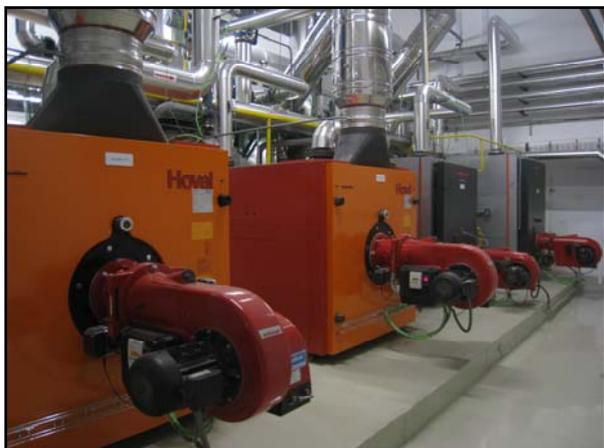
En total hay instaladas 15 calderas con una potencia instalada de 12.848 Kw. Algunas de las calderas son redundantes y casi todas disponen de quemador modulante para adaptarse a la demanda en cada momento.
