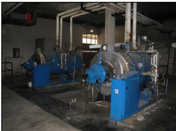
La sala de calderas del edificio está situada una edificación anexa y está integrada por 2 calderas de agua caliente a 80°C y 2 calderas de vapor A 170°C. Las calderas de agua están alimentadas con gasóleo C al igual que las calderas de vapor y tienen una antigüedad de más de 20 años.
