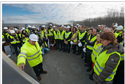
Un responsable de las obras explica a las autoridades la actuación que se está realizando.
