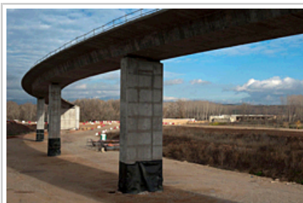
Futuro puente que unirá, salvando el río Ebro, los tramos navarro y riojano de la A-12.
