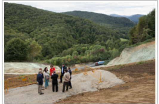
Las autoridades, en la zona superior de la ladera estabilizada.
