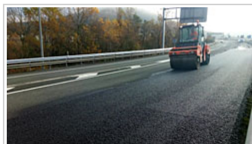
Trabajos de rehabilitación de firme.
