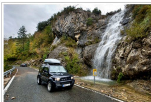
Una imagen de la NA-2130 afectada por las últimas lluvias.
