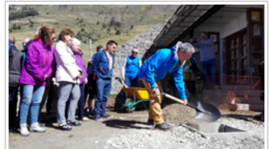
El vicepresidente de la FNDME coloca la primera piedra en presencia de la consejera Herrera.
