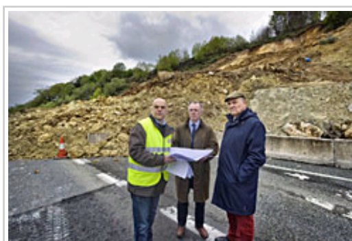
Serrano, Nagore y el consejero Zarraluqui, comprueban el alcance del desprendimiento.
