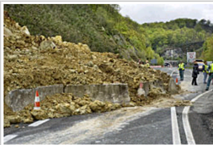
El desprendimiento, desde el lado sur.
