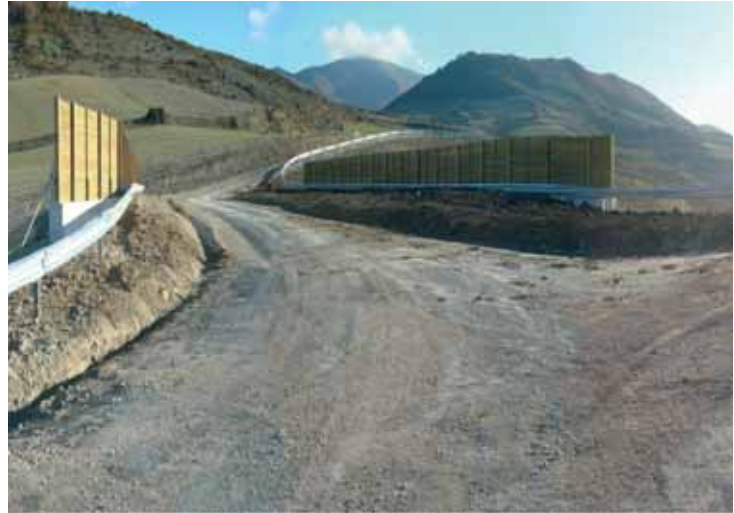
Paso Superior Multifuncional de 20 m para la Vía Pecuaria Pasada 31, camino rural y Paso de Fauna. En Arizko, Monreal.
