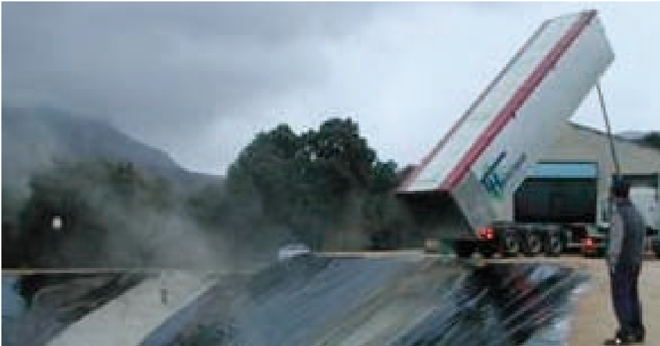
Imagen: Cubricación de balsas de purines con cubiertas flotantes (arlit, lámina de PVC, piezas hexagonales polipropileno).
