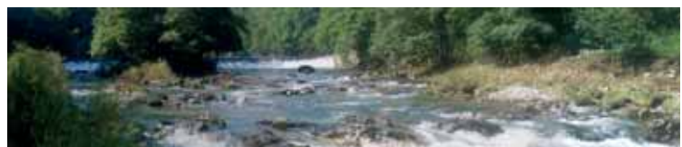
En la página, distintas imágenes del tramo del Río Bidasoa en el que se ha actuado con medidas correctoras y compensatorias para evitar impactos ambientales a consecuencia de las obras en la carretera N-121-A, tramo Bera/Vera de Bidasoa-Endarlatsa.
