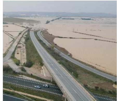
Inundaciones en Castejón.
